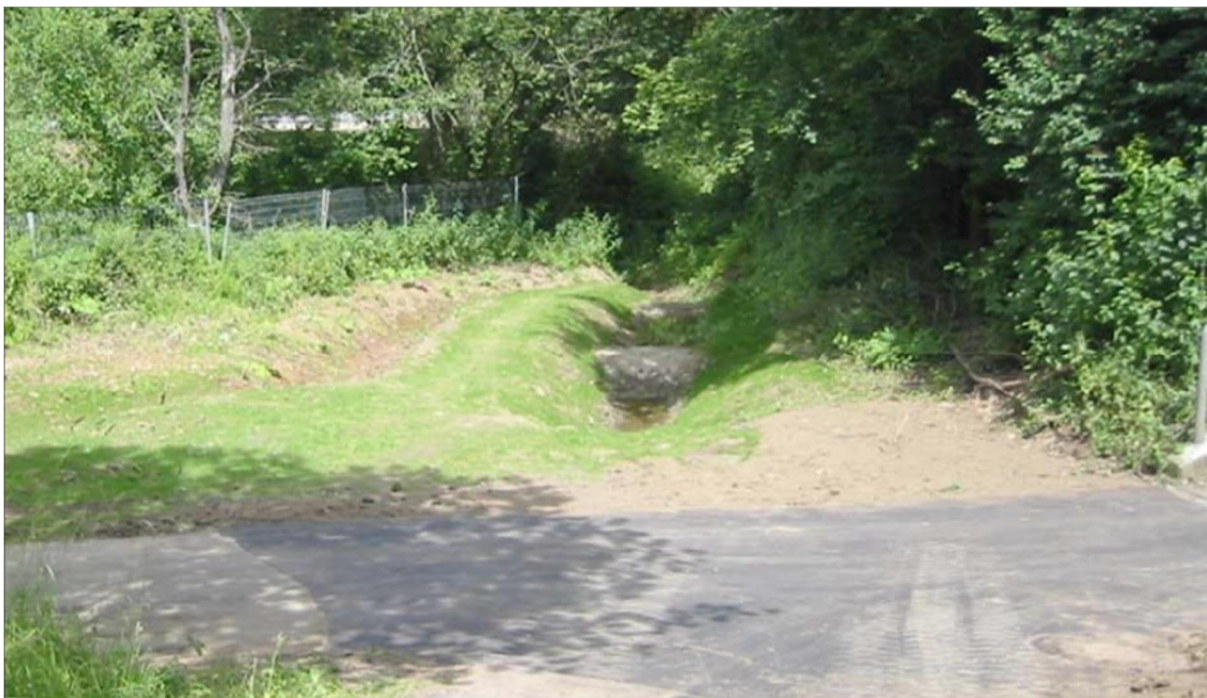
Figur 18. Exempel på dämmen i diken för att öka utjämningsvolymen och skapa trögare avrinning av dagvatten. Anläggning i den tyska staden Holzmulheim (Fachhochschule Münster, 2006).
