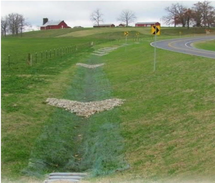
Figur 16. Exempel på dämmen i diken för att öka utjämningsvolymen och skapa trögare avrinning av dagvatten (MassDEP, 2017).
