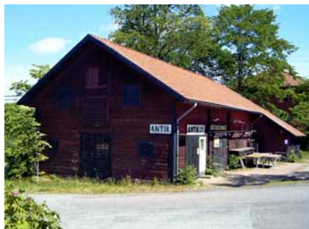
Magasinsbyggnad i trä, kv Höjden 8, Bergöös väg 2
