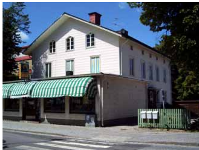
"Vita huset", Kv Bergöö 2, Östra Storgatan 3
